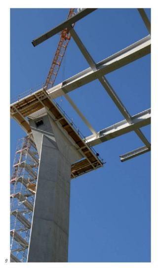
inférieures du mât sont bétonnées alternativement (gauche puis droite) à l'aide d'un seul outil de coffrage, ce qui requiert un dispositif de stabilisation diagonal sur la branche opposée (fig. 1). L'armature verticale du fût est essentiellement mise en œuvre au moyen de cages préfabriquées munies d'étriers fermés contenant quatre à six barres.
