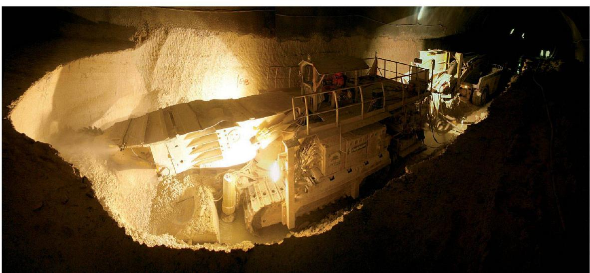
Fig. 5 et 6 : La proximité des immeubles et de la route exclut une excavation traditionnelle à l'explosif et rendent impossible le dégagement des surfaces d'installation et de stockage habituellement dédiées à des travaux de cette importance.
