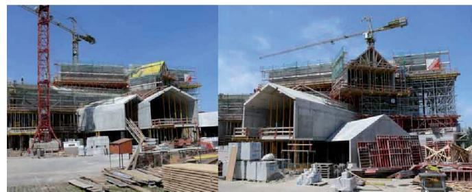
Fig. 9: Corps de bâtiment au rez-de-chaussé avec murs concaves
