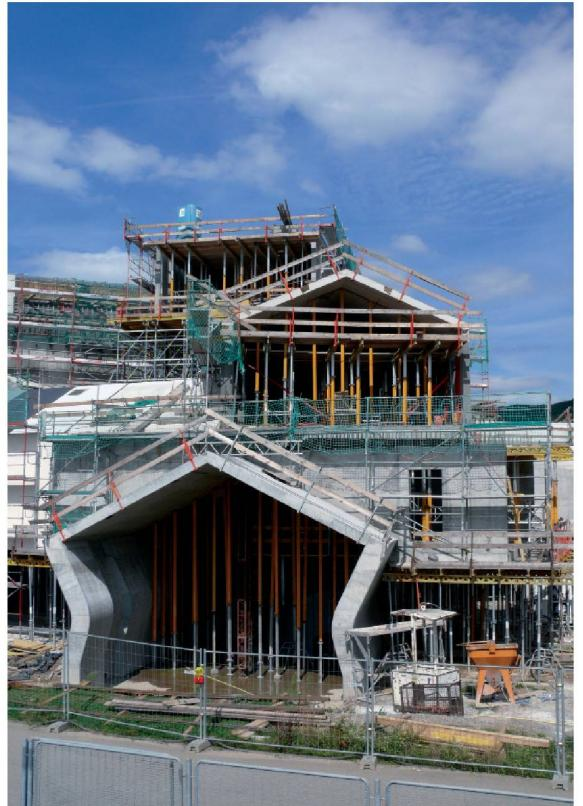
ments porteurs sont considérés, en matière de système statique, comme faisant partie d'un tout. Avec comme conséquence qu'une modification de la rigidité d'une partie du bâtiment peut avoir des effets sur la répartition des charges dans l'ensemble des éléments porteurs. Un des défis pour les ingénieurs était donc de pouvoir prédire de manière réaliste les conséquences de différentes transformations du système et de prévoir des contre-mesures efficaces.
