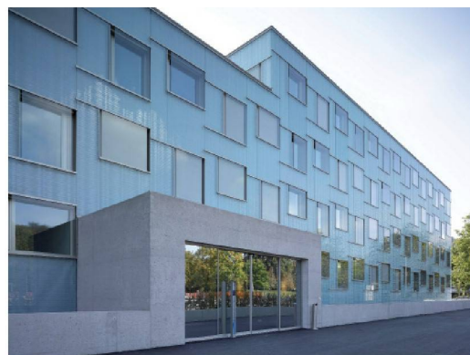
Bâtiment administratif Axpo, construit selon les objectifs de performance énergétique SIA (Meier Leder architectes, photo: Roger Frei)
