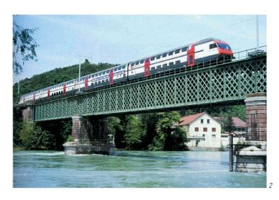
tée depuis 1999 par des trains de voyageurs CFF répondant aux exigences de la classe de ligne B1 (selon directive des chemins de fer européens: charge admissible par essieu de 180 kN, charge maximale linéaire de 50 kN/m).
