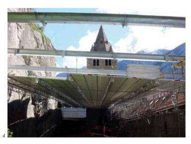
La toiture présente une légère inclinaison de 5% longitudinalement et transversalement, de façon à garantir l'écoulement des eaux de pluie. Un système d'arrosage automatique a été disposé au-dessus des tôles translucides pour éviter l'accumulation de feuilles ou de branches mortes provenant de la falaise. La sous-face de la toiture est quant à elle totalement étanche à l'eau.
