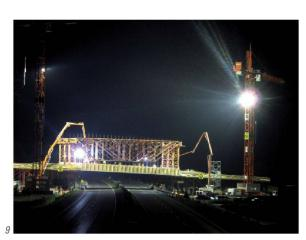
toute la nuit pour couler quelque 330 m³ de béton. Plusieurs mesures de contrôles qualité ont été effectuées, parmi lesquelles celle du contrôle de l'évolution de la flèche du cintre lors de la mise en place du béton: la flèche mesurée de 48 mm était très proche des 50 mm déterminés par le calcul, prouvant l'excellent travail de tous les intervenants.
