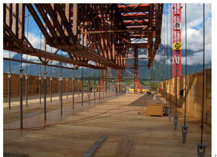
Fig. 8 : Coffrage et ferraillage du tablier sur le plateau
