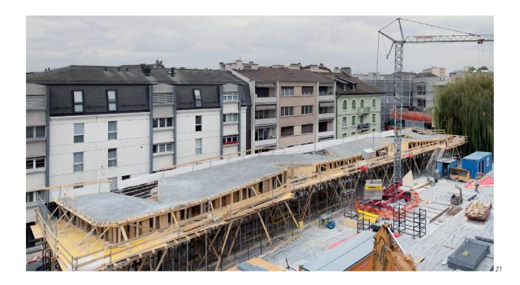
hauteur variant entre 4,5 m et 5 m, sa toiture en béton mince est portée par cinq faisceaux de trois poteaux inclinés. D'une hauteur statique de 15 cm, sa rigidité est assurée par un système de plis qui permet également l'écoulement des eaux de pluie. Cette structure plissée en béton, étudiée en collaboration avec le bureau d'ingénieurs Bonnard et Gardel, s'inspire de solutions sturcturelles dévelopées dans les années 1970.
