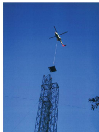
Montage d'un pylône (Photo Paul Glassey SA)
