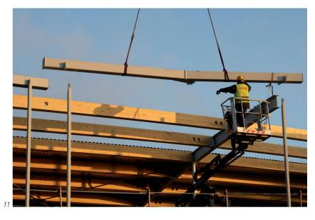
La dernière difficulté à signaler concernant le montage de la charpente tient aux délais imposés pour sa réalisation. Ces impératifs nous ont contraint à démarrer le montage dans les trois zones planes situées aux extrémités du bâtiment, les zones sur la coque en béton ayant démarré ultérieurement. Une contrainte qui accentuait considérablement les exigences de précision afin d'éviter tout problème lors des raccords entre les diverses zones.
