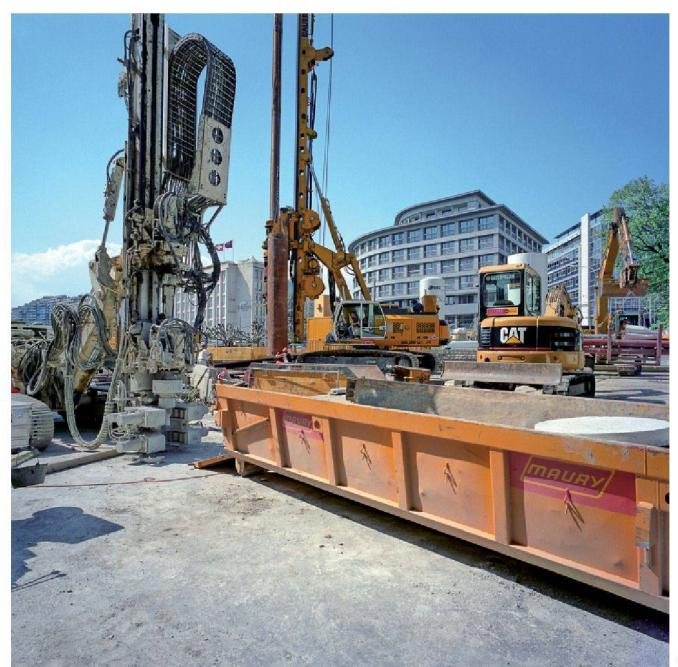
Fig. 12 à 14 : Phasage des travaux sur les ponts « aval » : après avoir réalisé les pieux et micropieux, le pont est démolie par sciage (12); réalisation du batardeau, réalisation des fondations, culées et piles centrales (13); pose du cintre supérieur et construction du tablier (14)
