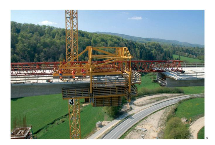
légèrement surcompenser les déformations pour garantir la qualité esthétique de l'ouvrage à long terme. Un tel calcul est nécessaire au suivi des nombreuses étapes de construction et à la maîtrise de ses aléas (fig. 11).
