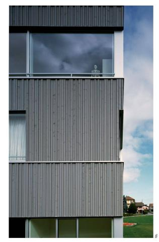
Fig. 6: Traitement spécifique de l'angle: le bandeau de fenêtres s'interrompt et laisse entrevoir les étapes du montage (Photo Jean-Michel Landecy)
