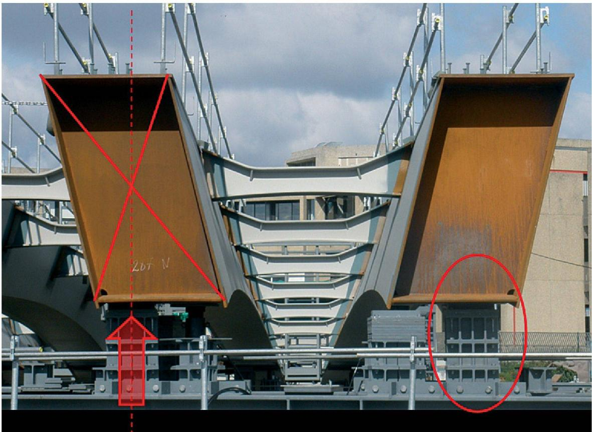
Fig. 18 : Appareaux pour centrer la réaction d'appui avant soudage des bracons sur le pied d'arc
