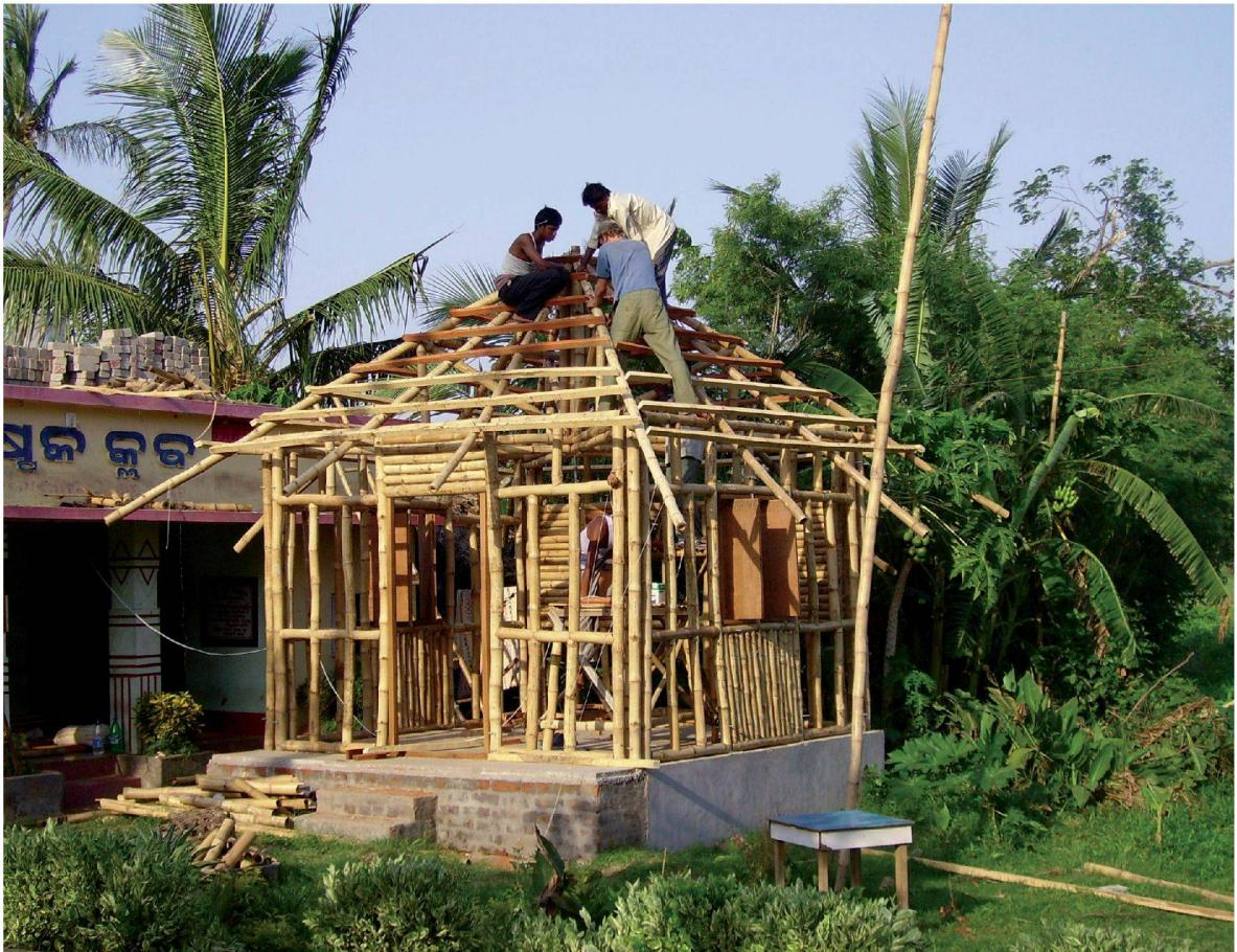
Fig. 1 : Ossature bambou contreventée
