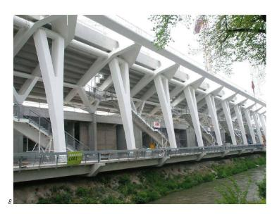
Au final, ce sont plus de 40 000 heures de travail en atelier qui ont été nécessaires à la fabrication de la moitié du stade, soit près de 2 000 heures par file, ou encore plus de 25 heures par tonne d'acier. Un chiffre qui illustre bien la complexité géométrique de la charpente métallique du stade, quand on sait qu'il faut compter de 5 à 10 heures par tonne pour une charpente de bâtiment ou de halle et qu'une réalisation nécessitant 15 heures par tonne est considérée comme très ouvragée.
