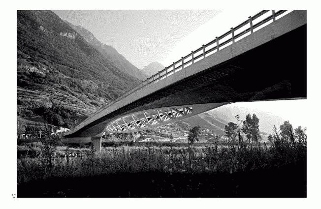
La fixation de la structure métallique a relié les deux côtés du pont, assemblant deux systèmes statiques jusqu'alors indépendants en un état proche de celui du pont définitif. A ce stade, le système fonctionne comme une poutre continue reposant sur quatre appuis (deux culées et deux piles intermédiaires), mais avec des matériaux différents.
