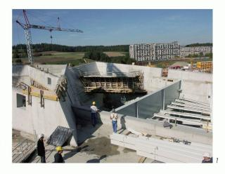
ailleurs, la géométrie particulière de l'ouvrage – qui comprend notamment des murs en béton d'une hauteur de 20 m inclinés à plus de 30° – impose un contrôle géométrique rigoureux du bétonnage: une variation de 0,5° dans la réalisation du fruit d'un mur engendrerait en effet une erreur de l'ordre de 30 mm sur la longueur des poutres.
