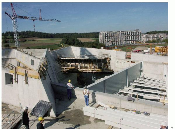
ailleurs, la géométrie particulière de l'ouvrage – qui comprend notamment des murs en béton d'une hauteur de 20 m inclinés à plus de 30° – impose un contrôle géométrique rigoureux du bétonnage : une variation de 0,5° dans la réalisation du fruit d'un mur engendrerait en effet une erreur de l'ordre de 30 mm sur la longueur des poutres.
