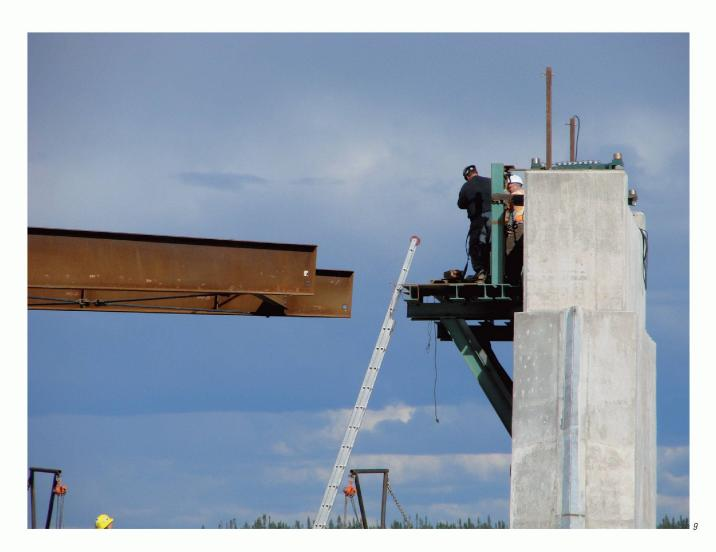
frottement baisse d'environ 50% et la force de poussage se voit réduite à une valeur comprise entre 10 et 15 tonnes par mètre. Dans de bonnes conditions, la vitesse d'avancement est approximativement de six pieds à la minute (ou 30 mm à la seconde).
