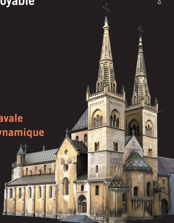
Ci-dessus : relevé lasérométrique de la Collégiale de Neuchâtel et modélisation 3D en qualité photographique, haute définition.
