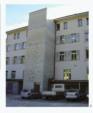
sont considérées comme des diaphragmes infiniment rigides en plan. La transmission des efforts horizontaux de séisme doit donc être assurée par la liaison entre les dalles et les nouveaux éléments de renforcement (fig. 4). En cours de chantier, des essais de traction sur les ancrages horizontaux ont permis de confirmer la capacité des dalles existantes à assurer le transfert des forces sismiques vers les structures de renforcement (fig. 6).
