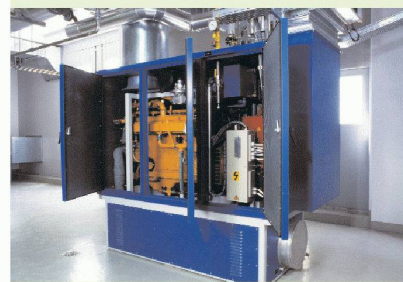
Couplage chaleur-force (CCF) équipé d'un moteur à gaz
