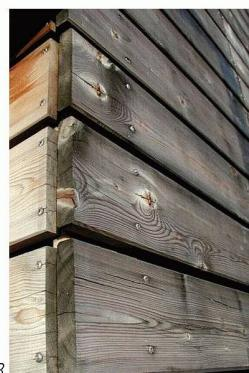
Fig. 1 : Altération de la couleur due aux intempéries – influences des passages de la chaleur (éléments de soutien intérieurs) et des saillies du toit
