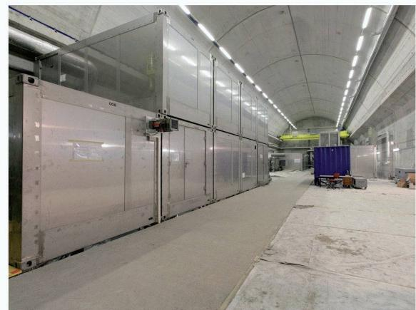
Fig. 8 : Train de bétonnage de la voie, chargement à la centrale à béton située sur la place d'installation de Raron
