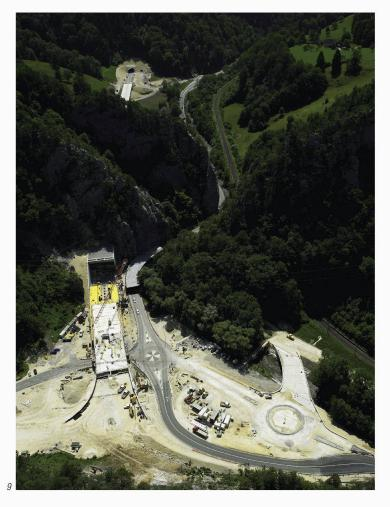
Les travaux de la demi-jonction à proprement parler ont débuté en 2005 par le déplacement du ruisseau de Rebeuvelier, suivi de celui la route cantonale RC 1566 qui a elle aussi été rattachée au giratoire provisoire (fig. 4). La construction du viaduc de la Verrerie et celle du pont Nord sur la Birse ont commencé en parallèle.
