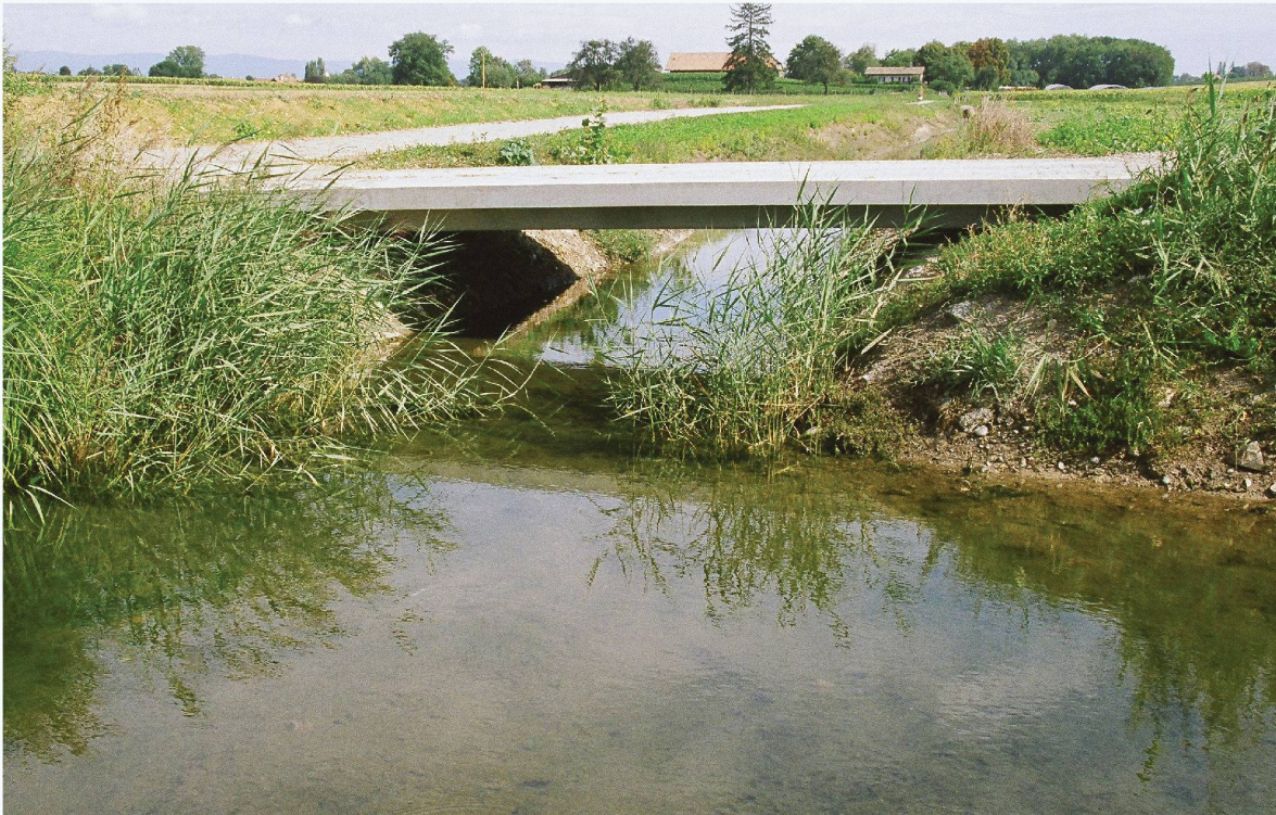
Fig. 17 : Vanne mobile à la hauteur du pont de La Motte (Photo O. Zimmermann)
