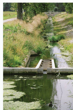
Renaturation de la Seymaz, échelle à poissons, première retenue à la jonction Seymaz / Chambotton (Photo Marie-Angèle Barthassat)
