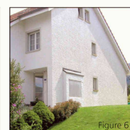
Système ITE avec structure minérale épaisse sur isolation EPS, Année de construction 1987
