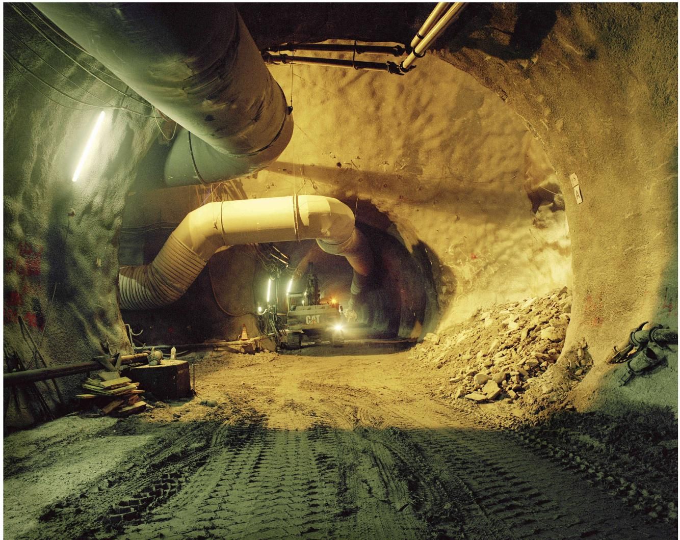
Fig. 4: Soutènement à travers la faille du tunnel Est
