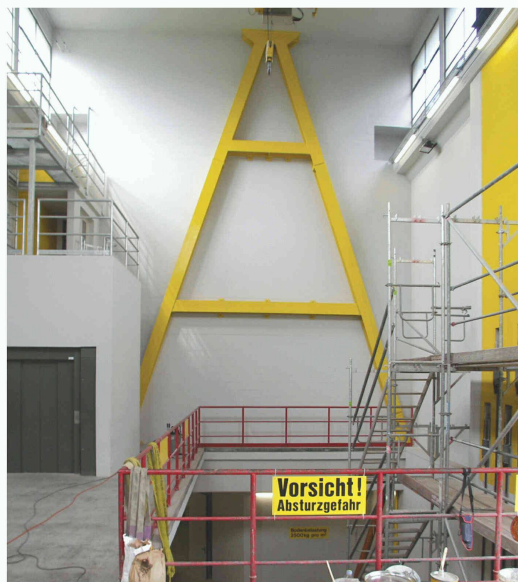
Dispositif parasismique en acier (jaune, à gauche) et en béton armé (jaune, à droite) (Image: Thomas Wenk)
