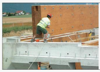
Assemblage Bois Béton sans connecteurs métalliques. H189 – Contournement Bulle Pont de Planchy Portée 29 m
