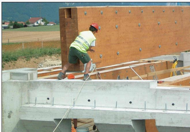
Assemblage Bois Béton sans connecteurs métalliques.
