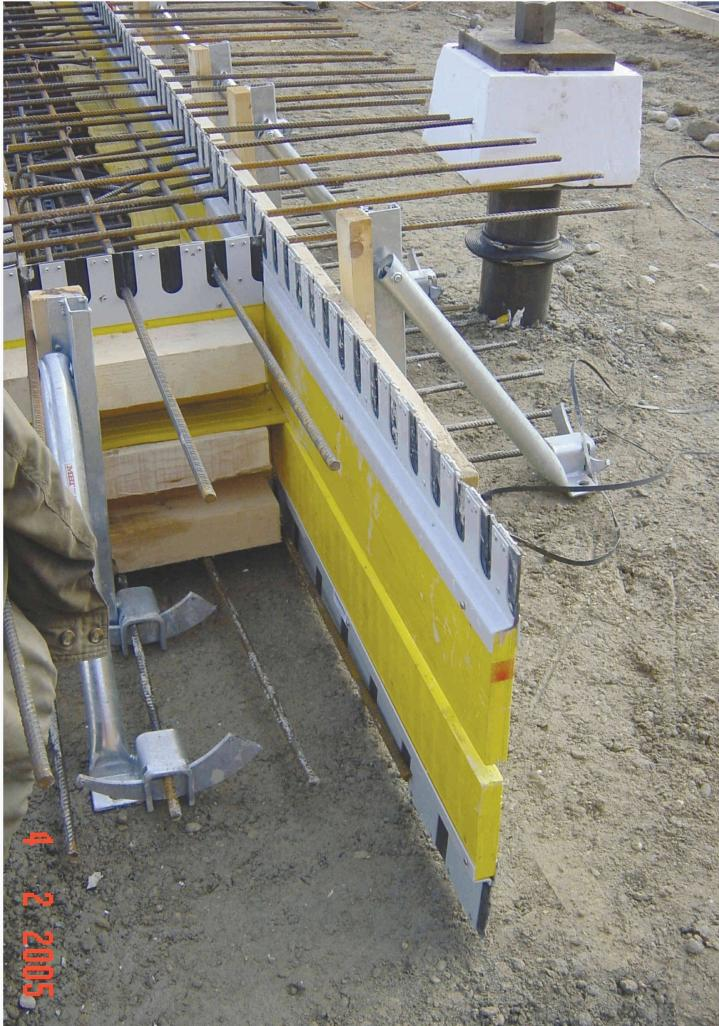
Ils réduisent les efforts parasites qui se développent immanquablement dans ce genre de structure. Par ailleurs, tous les joints de travail ont été pourvus de bande d'étanchéité afin d'éviter les infiltrations d'eau au droit de ces points faibles (fig. 4). Le concept prévoyait en outre qu'une attention toute particulière soit portée à la qualité des bétons, à l'ouverture des fissures, aux dimensions des étapes de bétonnage ainsi qu'aux traitements ultérieurs des bétons frais.
