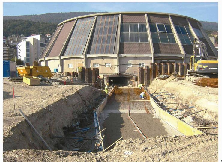
Fig. 1 : Jonction entre l'ancien collecteur (à gauche) et le nouveau (à droite).
