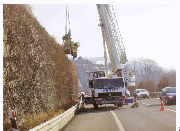
Fig. 1 : Travaux sous trafic : installation d'une foreuse en tête de mur
