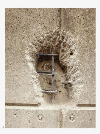
Les principales difficultés des investigations ont été d'une part la recherche de la tête d'ancrage - noyées dans le béton de l'ouvrage (fig. 3) ou enterrées sous le terrain naturel (fig. 4) - et d'autre part la mise au point d'un système de liaison fiable entre la tête et le vérin d'essai.
