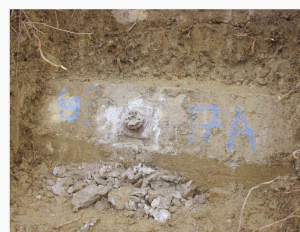
Tête d'ancrage délogée (Photo Bonnard&Gardel Ingénieurs-conseils SA)
