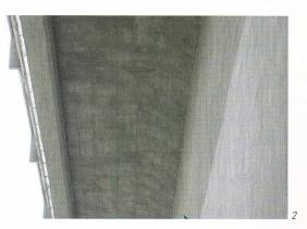
Fig. 1: Face inférieure de l'aile du tablier après enlèvement des éclats lors des travaux de 1994
