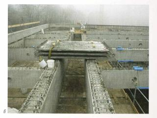
Fig. 5 : Poutres préfabriquées mise en place sur le coffrage des poutres principales. On distingue également les tours d'étayage de ces dernières.
