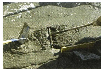
Le BEUP, à la fois autocompactant et rhéotrope, est travaillé avec des outils standards (Photo A. Herzog)
