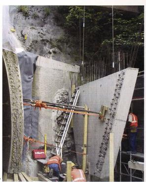
Fig. 1: Schématique de structure du portail Nord Fig. 2: Suspension provisoire du mur latéral préfabriqué Fig. 3: Mise en place du mur latéral, chaussée Lac du portail Nord Fig. 4: Aspect final du portail Nord (chaussée Lac) (Tous les documents illustrant cet article ont été fournis par l'auteur)
