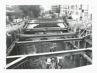
Les murs de ce puits sont constitués de parois de pieux jointifs d'un mètre de diamètre. Le puits est fondé sur un radier de 80 cm d'épaisseur encastré dans les pieux. La dalle de couverture est également encastrée dans les pieux. Deux niveaux d'étayage avec butons préfabriqués en béton armé complètent la structure du puits.
