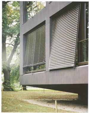
La façade porteuse complète l'idée de l'arborescence structurelle. Baies vitrées, terrasses extérieures et lamelles inclinées concourent à simuler le jeu de transparences, filtres et reflets d'une frondaison. Le bâtiment peut ainsi être « lu » comme un double houppier englobant presque jusqu'à terre deux fûts creux.
