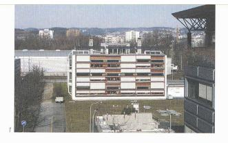
Fig. 1: Le bâtiment expérimental du LESO-PB, sur le campus de l'EPFL à Ecublens : les stores sont reliés au système de régulation expérimental qui est testé in situ. (Photo LESO-PB)
