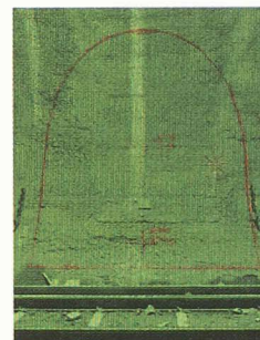
Profil de percement transversal, tunnel de base du Gothard (Photo Milo Keller, ECAL)
