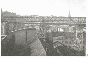
rieures, puis, successivement, les diagonales et membrures supérieures. Du côté de la Caroline, un léger échafaudage placé sur le bâtiment à toit plat facilita l'opération.
