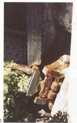
Quoique moins sévèrement attaquées, d'autres parties de la structure métallique sont également touchées par la corrosion: outre les surfaces les plus exposées aux intempéries, il s'agit notamment des montants et des entretoises proches des culées ainsi que des appareils d'appui à la naissance des arcs extérieurs, qui reçoivent les eaux d'infiltration provenant des joints de dilatation défectueux (fig. 6).
