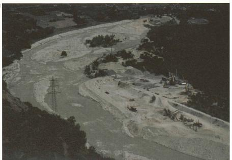
Fig. 14: Les matériaux d'excavation des tunnels CFF servent d'assise aux nouvelles voies pour la traversée d'une combe viticole: (a) avant les travaux et (b) en 2002.
