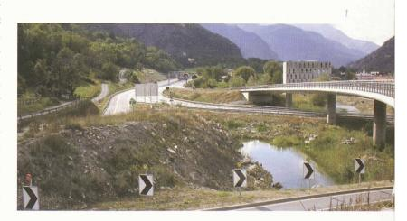
Fig. 1: Les biotopes créés au sein de la jonction A9 de Brigue remplissent le rôle de bassins de rétention pour les eaux de chaussée, traitées au préalable par un déshuileur. (Photo Arnold Steiner, SRCE-RN)
