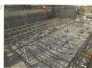
Aux exigences techniques s'ajoute une contrainte architecturale importante liée au gabarit légal de construction qui, compte tenu du nombre d'étages et des hauteurs libres d'atelier, oblige à optimiser l'épaisseur des structures porteuses des planchers. Au total, ce sont quelque 38 000 m² de planchers qui doivent répondre à toutes ces exigences et qui conditionnent la conception d'une structure porteuse particulière.
