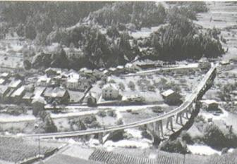
La structure de cet ouvrage est déterminée par la nécessité de reprendre et de transmettre aux fondations les efforts provenant de la courbure du tracé ferroviaire. La disposition des piles suit strictement la répartition optimale des moments des forces et détermine leur espacement variable tout au long du viaduc. Cet ouvrage est un véritable emblème de la région du bas Val de Bagnes, une image forte et sobre qui se lit spécialement depuis la route et constitue une sorte de portail monumental.
