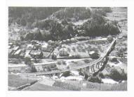
La structure de cet ouvrage est déterminée par la nécessité de reprendre et de transmettre aux fondations les efforts provenant de la courbure du tracé ferroviaire. La disposition des piles suit strictement la répartition optimale des moments des forces et détermine leur espacement variable tout au long du viaduc. Cet ouvrage est un véritable emblème de la région du bas Val de Bagne, une image forte et sobre qui se lit spécialement depuis la route et constitue une sorte de portail monumental.
